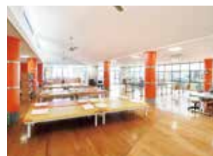
平成17年総合リハビリテーション施設増築
