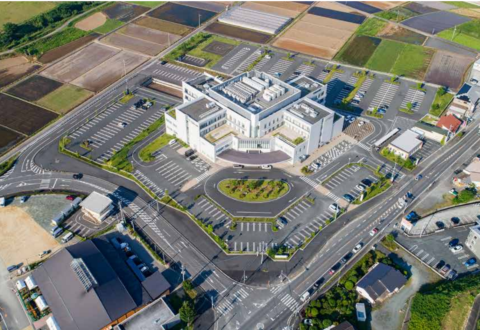
北東側から俯瞰した宇城総合病院
