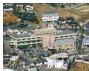
平成10年東外来棟増築
