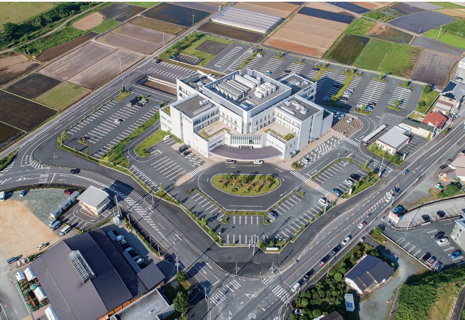
北東側から俯瞰した宇城総合病院
