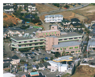
平成10年東外来棟増築
